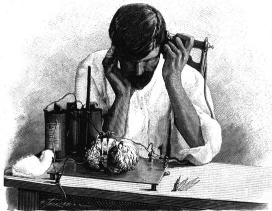
Fig. 2. — Réception des signaux à l'aide d'un collecteur d'ondes composé de deux aiguilles enfoncées dans un cerveau.
